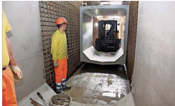
Die Elemente werden mit einem Kran in das neun Meter tiefe Loch eingelassen, mit einem Stapler zusammengeschoben und verankert.
