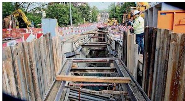
Der Bus kann ungehindert links an der Baustelle vorbeifahren.
